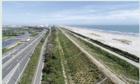
竣工した防潮堤
